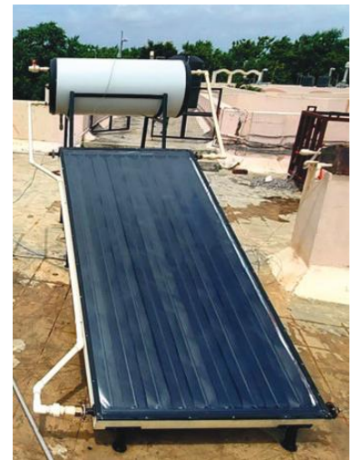
\text{CuMnNiO}_4 स्पिनल नैनोकण आधारित अवशोषक लेपित फ्लैट प्लेट कलेक्टर
