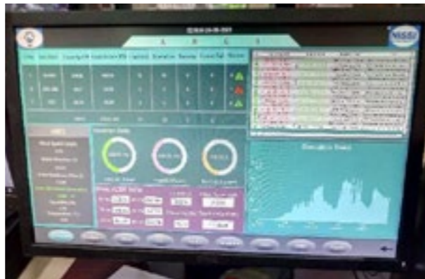
518 KWp सोलर प्लांट का SCADA यूजर इंटरफेस
