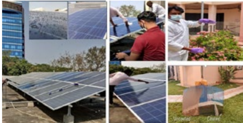
चित्र 1 रूफटॉप पीवी प्लांट (सोलर इनटिया पावर प्राइवेट लिमिटेड, मुंबई) में प्रौद्योगिकी प्रदर्शन और वास्तुकला कांच और ऑटोमोबाइल विंडशील्ड पर अन्य अनुप्रयोग
