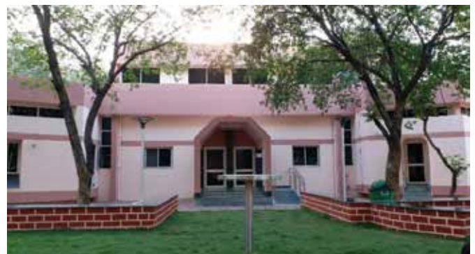
संशोधित कैटीन भवन का निर्माण
